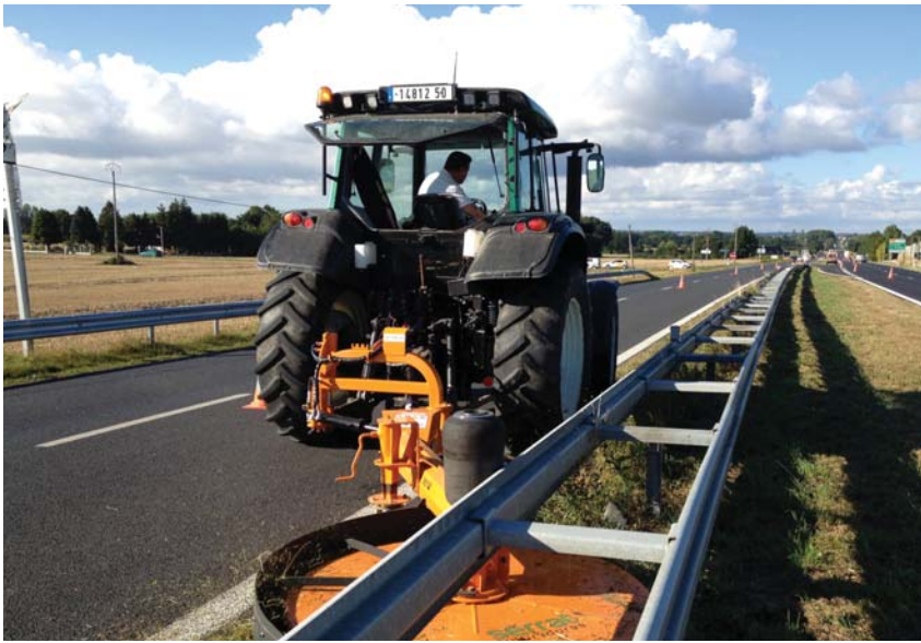
Control de trabajo vertical
